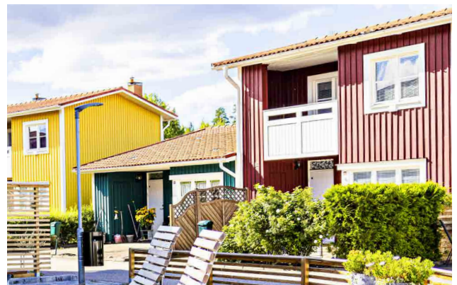
Vi har installerat nya värmeväxlare på Skraddargränd (Dalhem) som har löst varmvattenfrågan i vinter.
