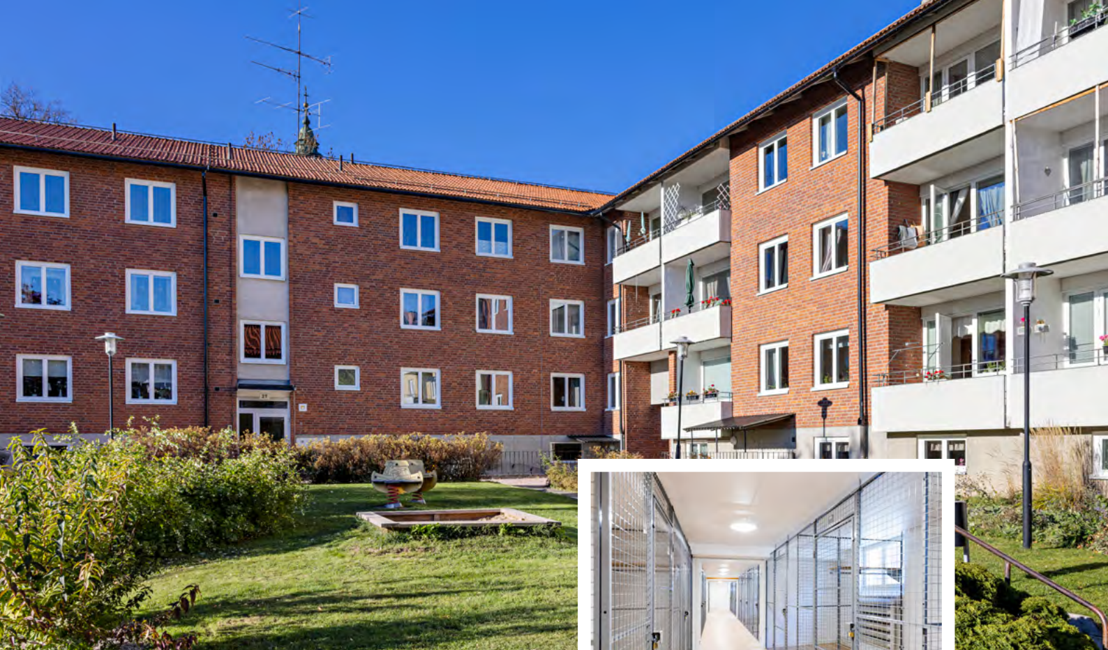
Fönstren på Konstmästaren är utbytta och slutbesiktade. De nya förråden är på plats i källaren.
