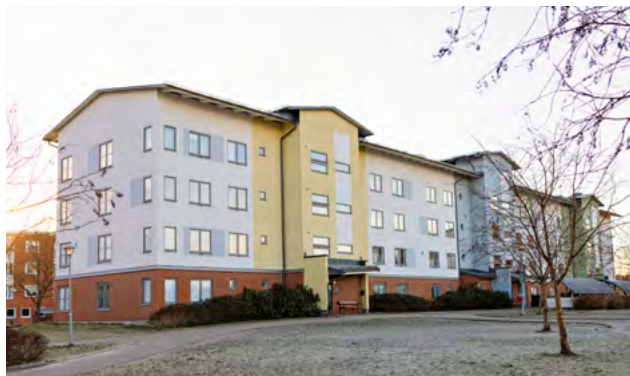
I december kommer Bravida (entreprenör inom elservice) installera rumsgivare i alla lägenheter på Johannesbergsgatan 11 A-C. På displayen kommer temperatur och fukthalt visas. Med givarna får vi lättare kontroll och kan reglera inomhusmiljön då det idag finns stora skillnader på temperaturen mellan lägenheterna.
