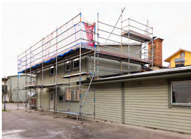
Vi lägger om taket på Trädgårdsgatan 6 som innefattar en lokal och förråd. Det med tanke på livslängden på yttskiktet.
