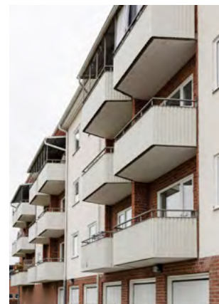
Nya fönster och dörrar ger en bättre och tryggare inomhusmiljö.
