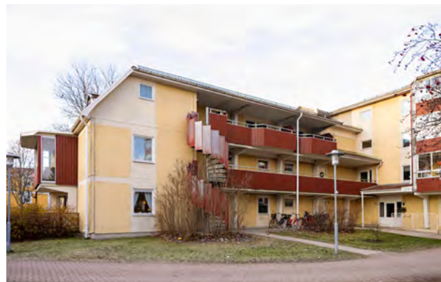
På Täljstenen, Väsbygatan 5, förlängs spiraltrapporna på utsidan av fasaden upp mot vinden. Det underlättar för både personal och entreprenörer att lättare få åtkomst till vindstrymmen utan att vi behöver störa våra hyresgäster.
