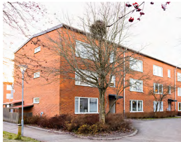
Under början av nästa år kommer vi att installera rumsgivare på Jakobsbergsgatan 12-16.
