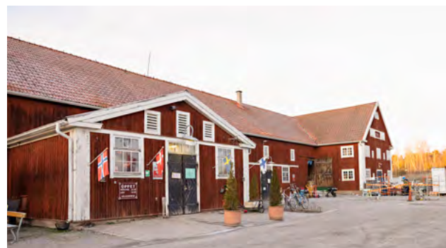
På Strömsbacka har pelletspannan bytts ut till bergvärme. Arbetet utfördes av BGE.
