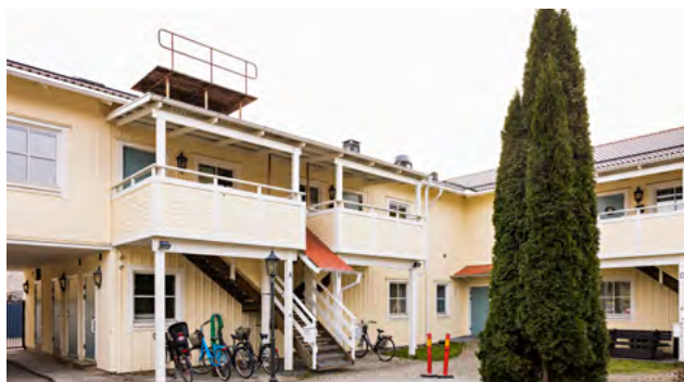
Vi kommer att montera in rumsgivare på Brunngatan 36-38 innan året är slut.
