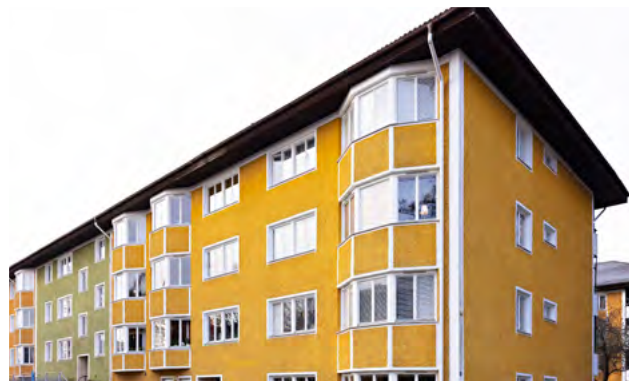
På Hyttgatan 8 och Brunnsgatan 1 pågår isolering av vindsförråden. Den totala ytan ligger på 2 158 kvm.
