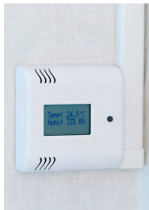
Ett nytt ventilationssystem ger lägre energiförbrukning.
