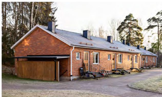
I Sätträbrunn kommer samtliga vindar att isoleras. Den totala ytan ligger på 1 714 kvm.
