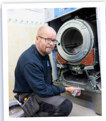
Thomas Andersson reparerar tvättmaskinerna på Salabostäder. Han ser ofta skador orsakade av överdosering av tvättmedel.
