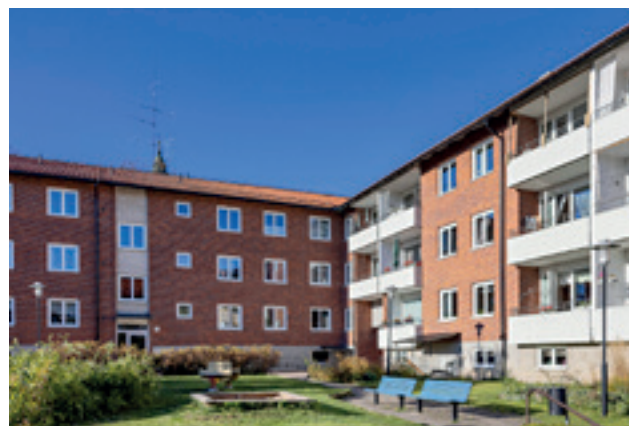
Hyresgästerna på Konstnästaren har nu flyttat sitt innehav till de nya förråden i källaren. Det har varit mer tidskrävande än planerat men nu förbereds isoleringen av vindarna.
