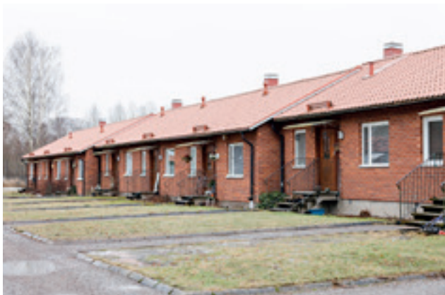
Vi kommer att byta 25 entrétak i Salbohed.
