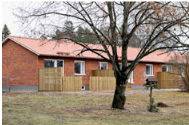
Vi har lagt om inkommande vatten och avlopp på Östergårdsvägen 12 i Salbohed.
