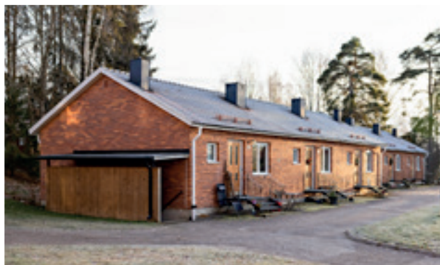
I Sättrabrunn är samtliga vindar nu isolerade.
