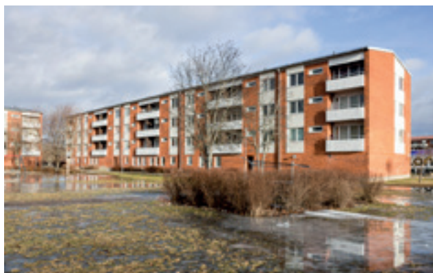
På Berggatan 16, 18 och 20 är armaturerna i trapphusen bytta. Det kommer alltid att vara en svag grundbelysning tänd eftersom trapphusen saknar fönster. Rörelsesensorer tänds belysningen helt så länge någon befinner sig i trapphuset.
