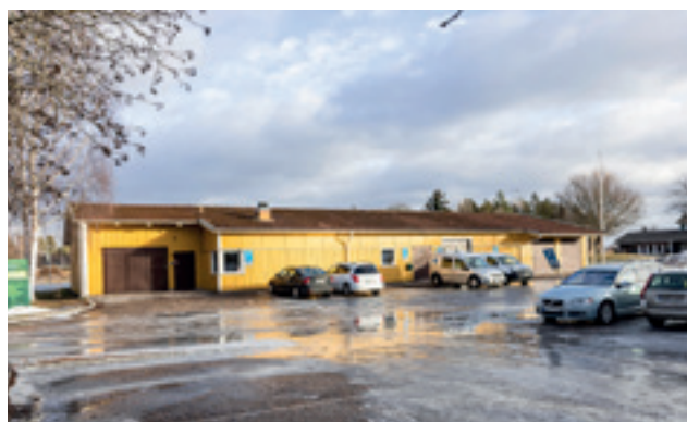
På vårt snickeri på Måns Olsväg 1 ska det dåliga taket bytas ut. Projektet beräknas utföras nu under vår/sommar.
