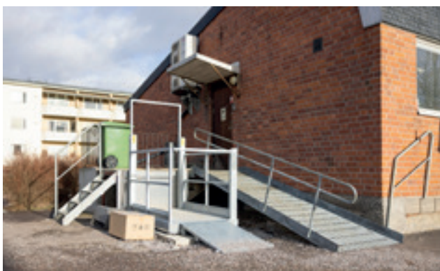
En hiss har installerats till lastkajen på Skolstigen för att underlätta lastning och hantering av otympliga och tunga vitvaror.
